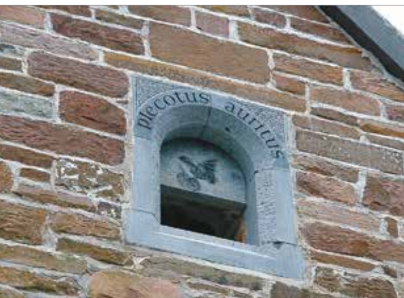
Illustration 17. Entrée de gîte réservée aux chauves-souris (aussi utilisée par des Petits rhinolophes), Irlande.
