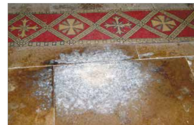
Illustration 13. Dégâts sur la pierre au prieuré de Penmon, Pays de Galles, Royaume-Uni, par suite d'une exposition prolongée à l'urine de chauves-souris.
