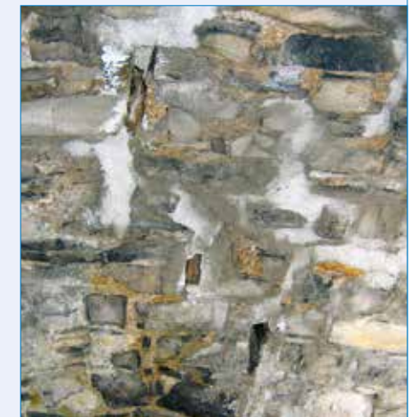
Illustration 22. Dessous du pont de Lisconny, montrant les trois sections de la profonde fissure, laissées ouvertes pour héberger la nurserie de Myotis daubentonii . Le gîte de mise bas est situé dans la section la plus basse. Noter que la maçonnerie fut soigneusement jointoyée autour des pierres, sans les recouvrir. © C. Shiel
