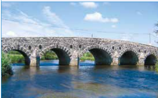
Illustration 21. Lisconny Bridge, Irlande, après restauration. © C. Shiel
