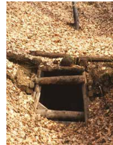
Entrée de la mine Király-bányák avant travaux de consolidation.
