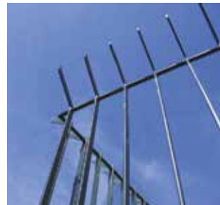
Détail du haut de la clôture.
