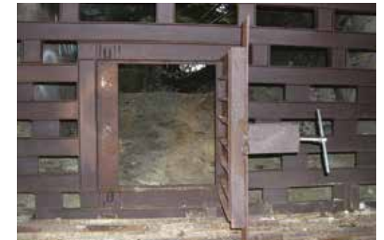
Porte de haute sécurité à Gauberg, Allemagne.
