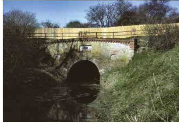
Entrée du tunnel de Greywell, Grande Bretagne.
