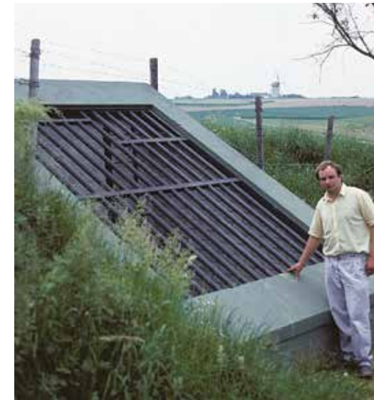
Grille à l'entrée d'une grande mine dans le sud Limbourg, Pays Bas.
