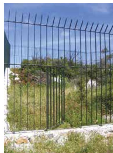
Porte dans la clôture.
