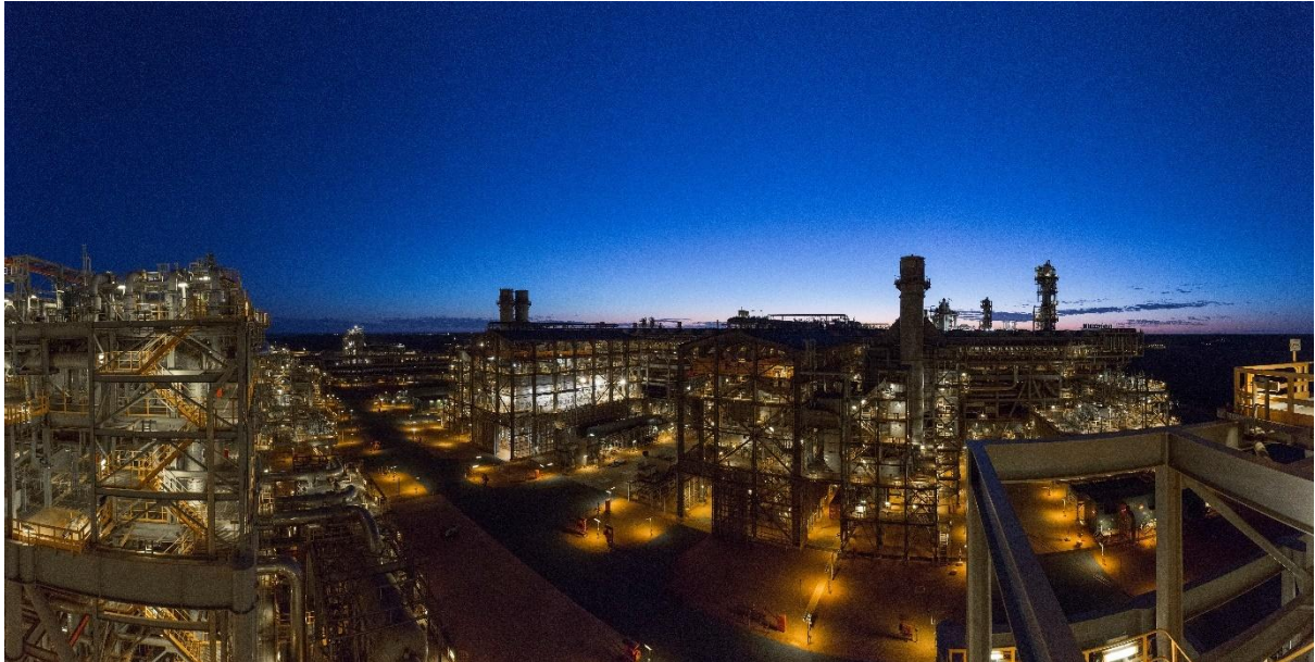
Figura 6. Planta de gas natural licuado en la isla Barrow Fotografía: Chevron Australia.
