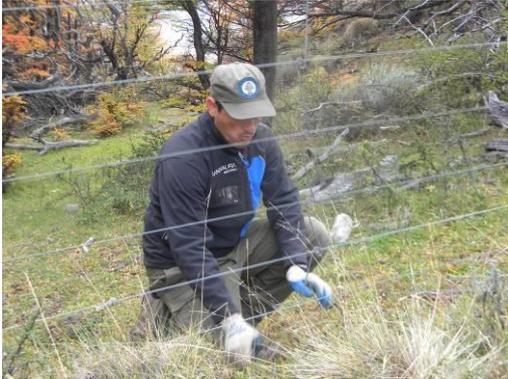
2° etapa: Adecuación del alambrado preexistente. Retiro de varillas intermedias (en este caso de alambre) y retiro del hilo superior de púa.
