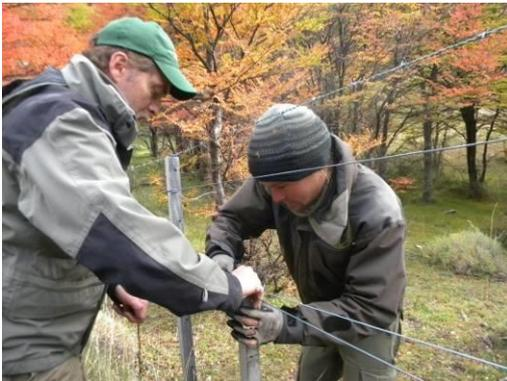
4° etapa: Colocación de la varilla de madera separando el hilo 3° del 4° (la parte inferior de la ventana debe quedar a aprox. unos 45 cm del suelo). Sujeción de la varilla y los hilos con alambre dulce.
