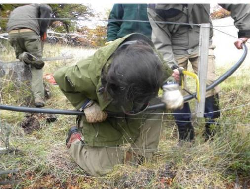
5° etapa: Colocación de la manguera (previamente abierta a lo largo) envolviendo los hilos inferiores y sujeción de la misma con precintos o alambre.
