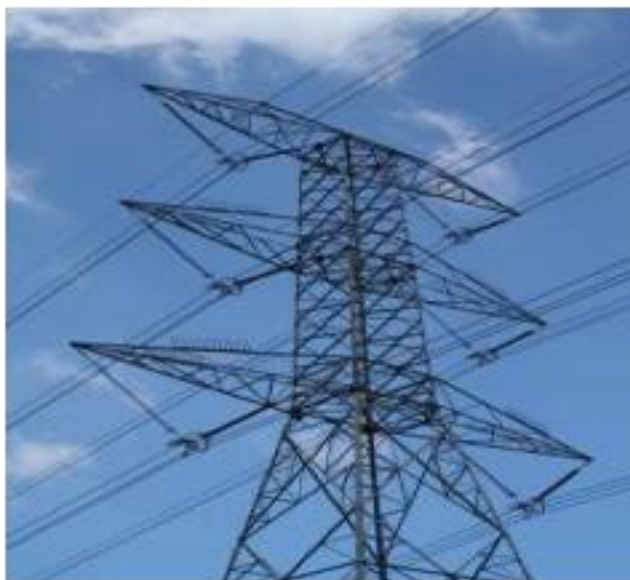
Figure 18 : Configuration verticale des câbles, ceux-ci étant disposés sur quatre niveaux (trois câbles de phase et un câble de terre). À comparer aux figures ci-dessus où la configuration horizontale permet de disposer des câbles sur deux niveaux seulement. Les arrangements verticaux à niveaux multiples sont plus dangereux pour les oiseaux car ils présentent un obstacle sur un plan plus grand (Photo : EWT-WEP).
