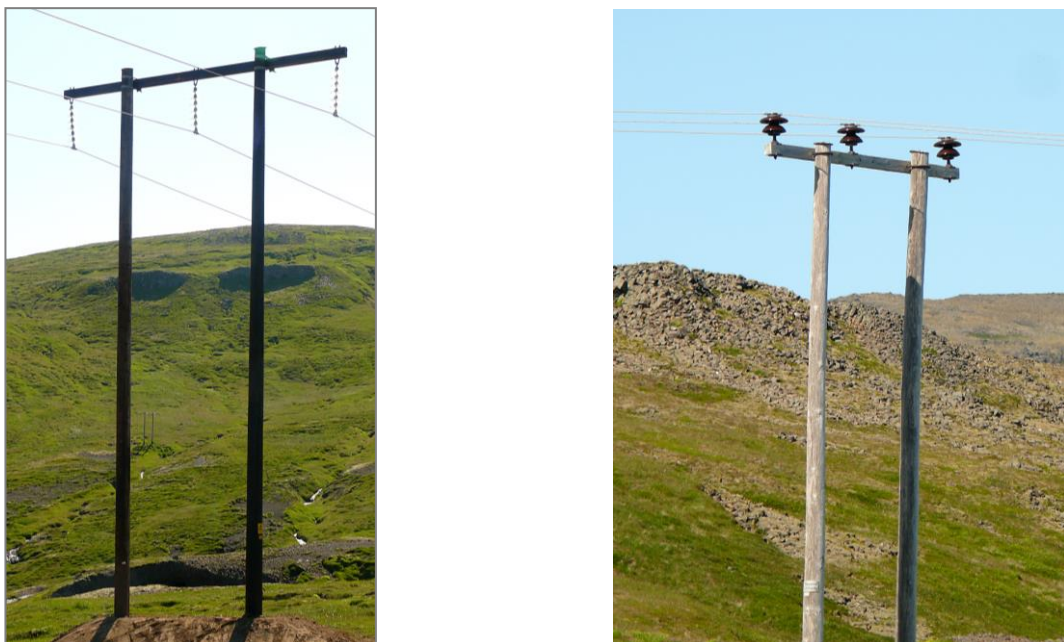
Figure 4 : À gauche : Ligne basse tension, horizontale, sûre, présentant trois câbles suspendus sous une traverse avec isolateurs suffisamment longs. À droite : Ligne basse tension en Islande, dangereuse pour les échassiers, ici Courlis corlieu ( Numenius phaeopus ) et Barge à queue noire ( Limosa limosa islandica ) et grands rapaces tels que Pygargue à queue blanche ( Haliaeetus albicilla ) et Faucon gerfaut ( Falco rusticolus ) du fait des conducteurs fixés sur des isolateurs trop courts au sommet de la traverse. Dans ce cas l'amélioration pourrait comprendre l'isolation du câble central et/ou le recouvrement des isolateurs (Photo : Bureau Waardenburg).
