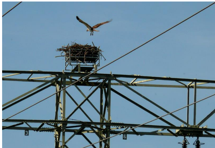
Figure 15 : Nidification d'un balbuzard pêcheur sur une plateforme artificielle de ligne moyenne tension, parc national de Murtitz, Allemagne (Photo; Bureau Waardenburg).
