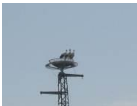
Figure 14 : Exemple de dispositif de perchage pour les cigognes en Algérie (photo de gauche : questionnaire retourné par l'Algérie ; S.Hamida, chef du bureau zones humides, Direction générale des forêts, Algérie, in litt.) et exemple au Portugal d'un pylône avec plateforme de nidification pour cigognes blanches afin de les attirer et d'éviter qu'elles ne nidifient dans les mâts des lignes électriques (photo de droite : Carlos Tiago).
