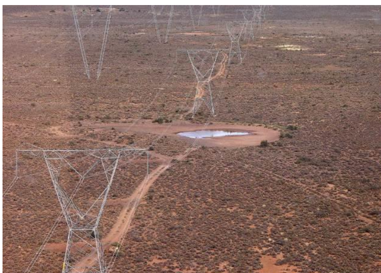
Figure 1 : Deux lignes de transport électriques adjacentes dans la région de Karoo en Afrique du Sud. La somme des impacts sur les oiseaux quand deux lignes se côtoient dans un espace restreint peut être beaucoup moins importante que lorsque ces lignes sont positionnées loin l'une de l'autre (Photo : EWT-WEP).
