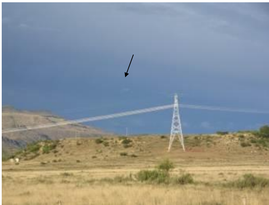
Figure 16 : Ligne de 400 kV, tous les conducteurs se trouvant sur le même plan horizontal. Cette image montre aussi le mince câble de terre presque invisible (flèche noire) en haut (Photo : EWT-WEP).
