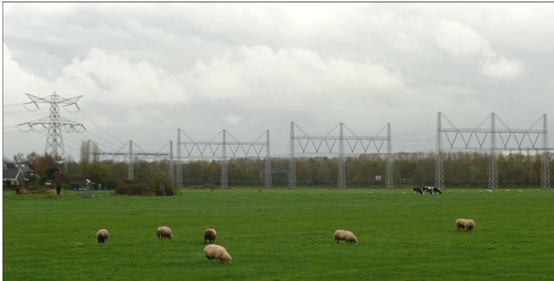
Figure 7. Une ligne de 380 kV sur laquelle les câbles conducteurs sont abaissés et suspendus à des portiques en un seul plan horizontal pour réduire les risques de collision des Grands Cormorans ( Phalacrocorax carbo ), des Spatules blanches ( Platalea leucorodia ) et des Hérons pourprés ( Ardea purpurea ) qui survolent quotidiennement ce tronçon de ligne situé entre leurs colonies et leurs zones d'alimentation, Muiden, Pays-Bas (Photo: Bureau Waardenburg).
