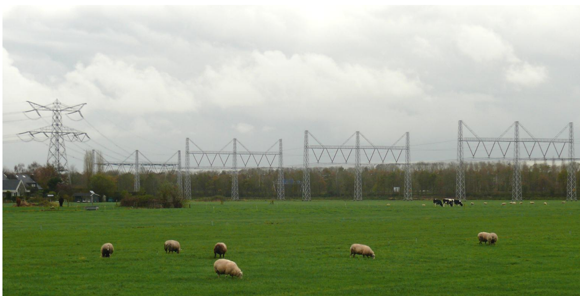
Figure 17. Ligne de 380 kV, les câbles étant suspendus plus bas sur des portiques sur un seul plan horizontal afin de réduire les risques de collisions pour le grand cormoran ( Phalacrocorax carbo ), la spatule blanche ( Platalea leucorodia ) et le héron pourpré ( Ardea purpurea ) passant tous les jours au-dessus de cette ligne en faisant des aller-retour entre la colonie en reproduction et les zones d'alimentation, Muiden, les Pays-Bas (Photo : Bureau Waardenburg).
