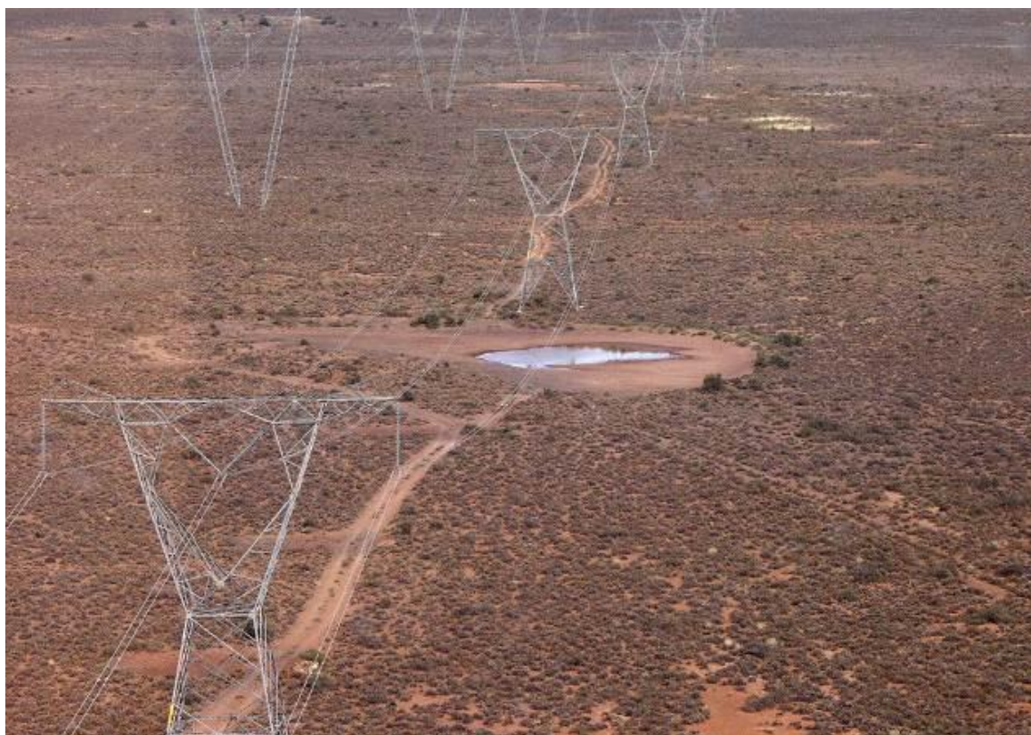
Figure 1. Deux lignes de transport électriques adjacentes dans la région de Karoo en Afrique du Sud. La somme des impacts sur les oiseaux quand deux lignes se côtoient dans un espace restreint peut être beaucoup moins importante que lorsque ces lignes sont positionnées loin l'une de l'autre (Photo : EWT-WEP).
