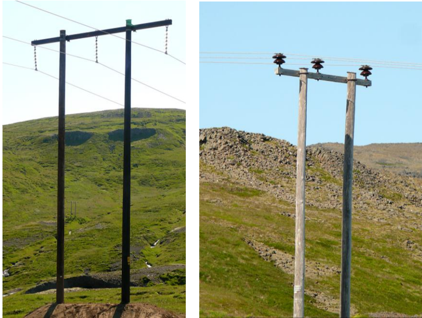
Figure 4. À gauche : Ligne basse tension, horizontale, sûre, présentant trois câbles suspendus sous une traverse avec isolateurs suffisamment longs. À droite : Ligne basse tension en Islande, dangereuse pour les échassiers, ici Courlis corlieu ( Numenius phaeopus ) et Barge à queue noire ( Limosalimosaislandica ) et grands rapaces (dans ce cas Pygargue à queue blanche ( Haliaeetus albicilla ) et Faucon gerfaut ( Falco rusticolus )) du fait des conducteurs fixés sur des isolateurs trop courts au sommet de la traverse. Dans ce cas l'amélioration pourrait comprendre l'isolation du câble central et/ou le recouvrement des isolateurs (Photo : Bureau Waardenburg).
