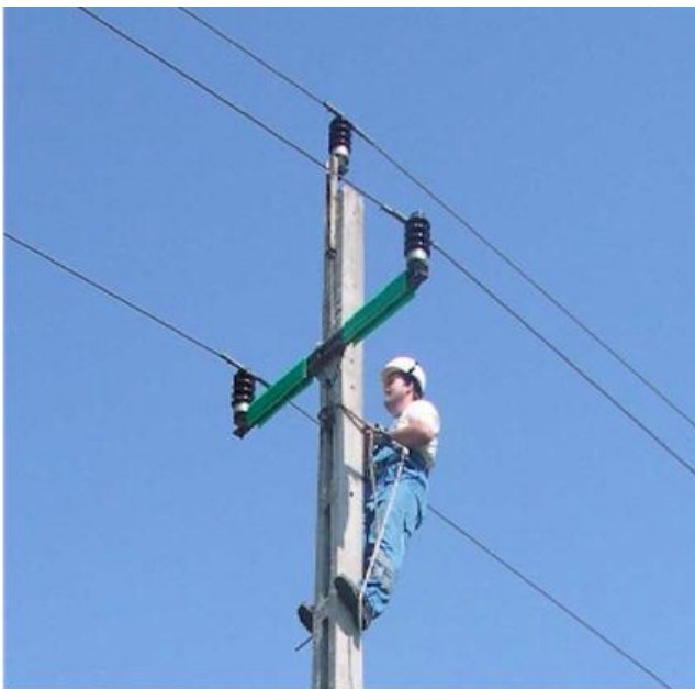
Figure 7. Isolation d'une traverse effectuée en Hongrie (source : Horvath et al., 2011).
